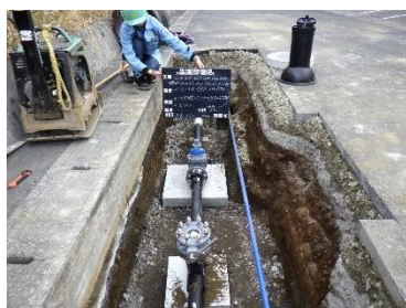
貯水槽に水を送るパイプラインの敷設工事
