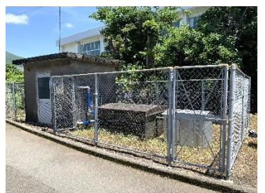
水源の井戸とポンプ小屋
