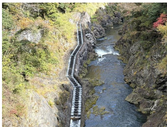
白丸ダム魚道
