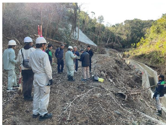
災害査定の様子
