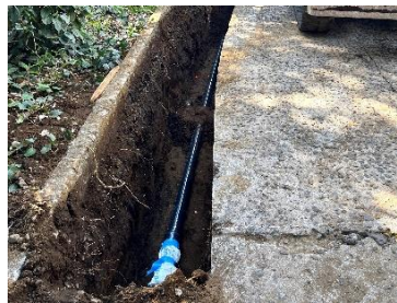
農地に水を送るパイプラインの敷設工事
