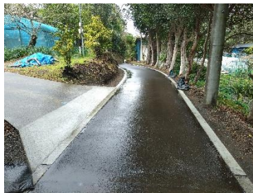
整備された泉津農道
