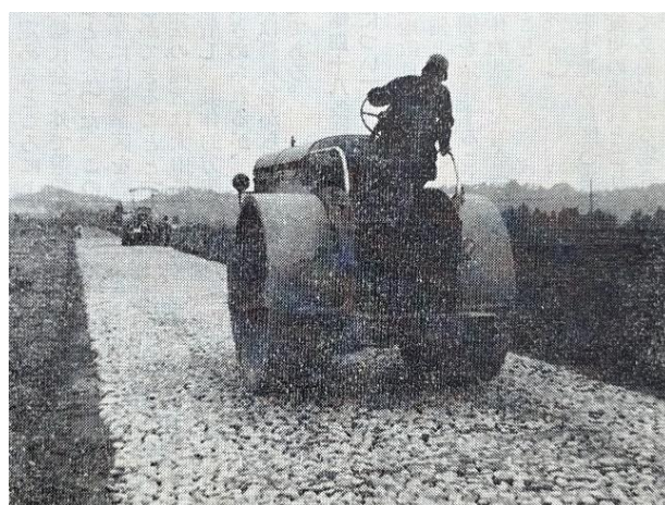
—第44号— 昭和39年9月1日 同農道の碎石転圧作業
