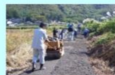
土砂道の補修
