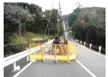
周辺のボーリング調査
