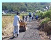
土砂道の補修
