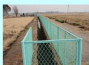
安全施設の整備
