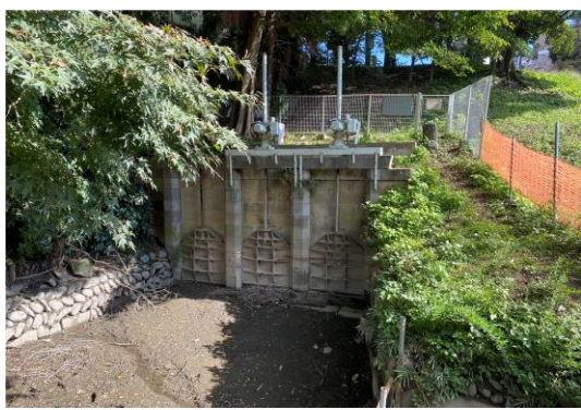
▲府中用水樋門
