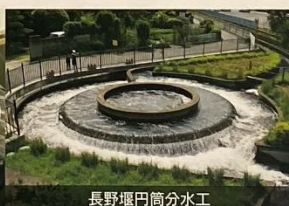
長野堰円筒分水工
