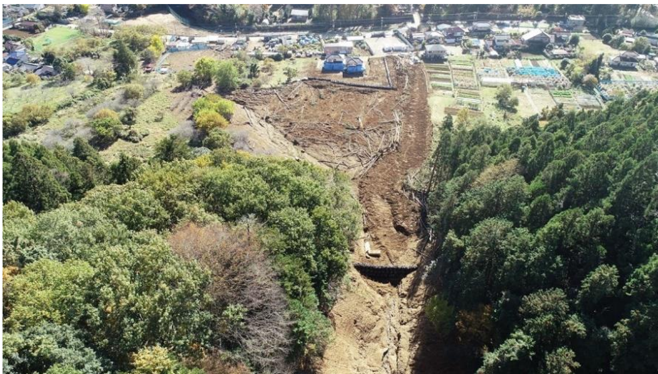
台風19号 農地への土砂流入（八王子市）
