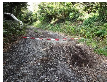
工事前の農道
