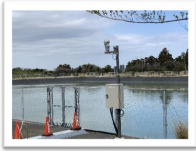
貯水池の遠隔監視カメラ・大島町
