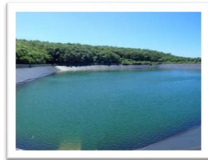
復旧した貯水池
