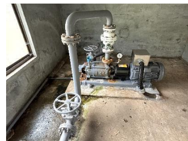
水源から貯水槽に水を送るポンプ敷設工事
