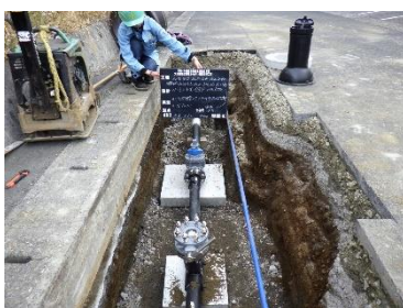
貯水槽に水を送るパイプラインの敷設工事
