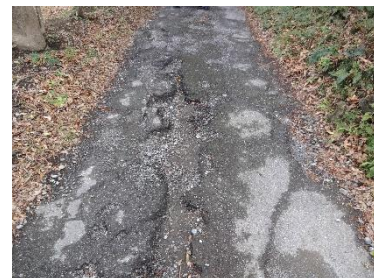
施行前の泉津農道
